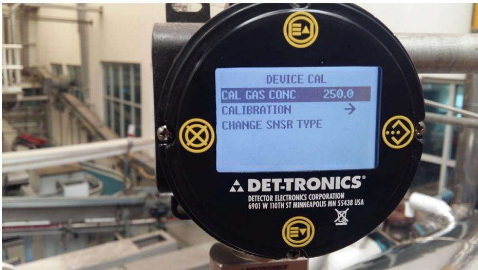
SE ENCUENTRAN EQUIPOS DESCALIBRADOS ENTRE 100 Y 50 PPM SE REALIZA CALIBRACION DE ZERO Y SPAN A 250 PPM DE CUERDO A RANGO Y CARACTERISTICAS DE LOS EQUIPOS TRANSMISOR MODELO UD10A525T2 , LOS SENSORES SE ENCUENTRAN DETRO DE UN RANGO ACEPTABLE PARA REALIZAR SU CALIBRACION.
