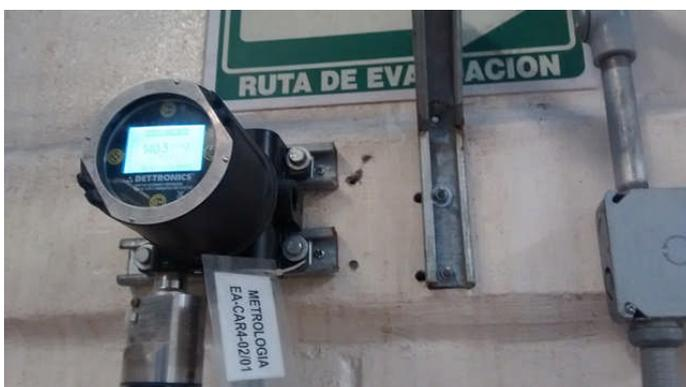
SE REALIZA COLOCACION DE CALCAS CON FECHA EN COLOR VERDE A EQUIPOS APROBADOS DURANTE LA CALIBRACION, EN ZONA COMPRESORES EN LOS 10 EQUIPOS INTERVENIDOS SE REALIZO UNA CALIBRACION EXITOSA.
