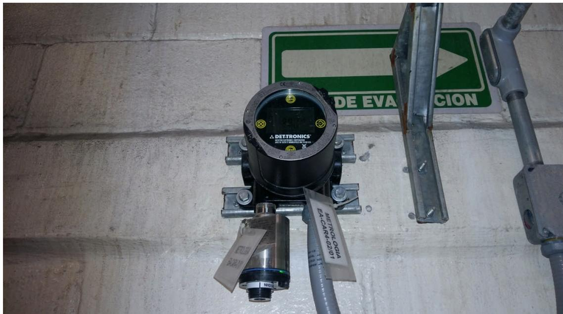
EN ZONA COMPRESORES SE INICIA CON LA CALIBRACION DE LOS EQUIPOS DE DETECCION DE GAS DETTRONICS (NH3) EL RANGO TOTAL DE ESTOS EQUIPOS ES DE 500 PPM , EL RANGO DE CALIBRACION DEBE SER A 250 PPM , ESTOS EQUIPOS CUENTAN CON UNA SOLA ALARMA A 50 PPM.
